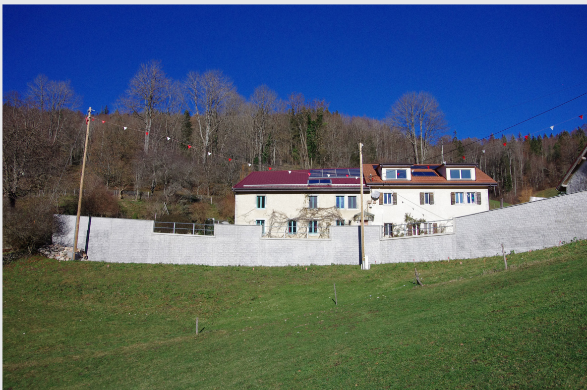
Nouveau mur de soutènement à La Villette
