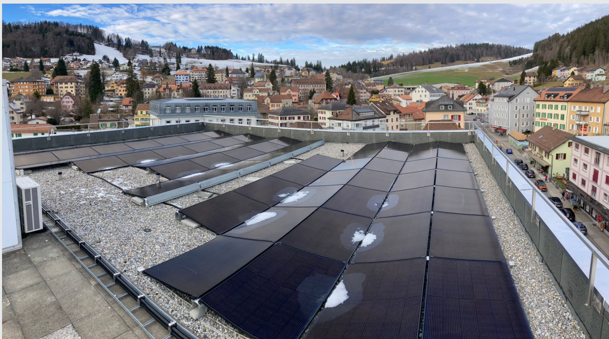
Installation photovoltaïque sur le toit de l'Hôtel de Ville
