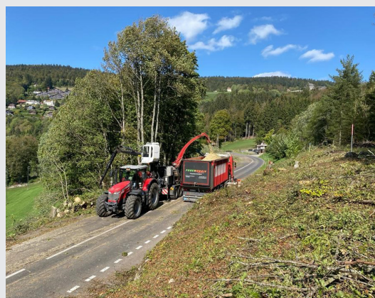
Intervention aux abords de la route cantonale près du Château
