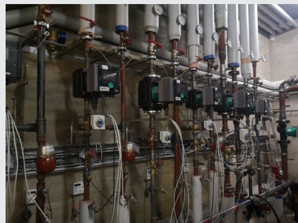
Travaux partie secondaire Chauffage à distance
