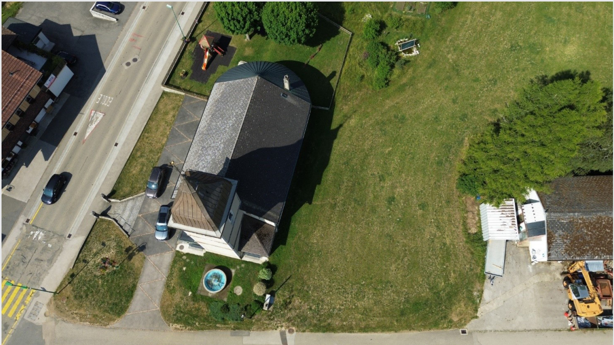
Situation avant travaux
