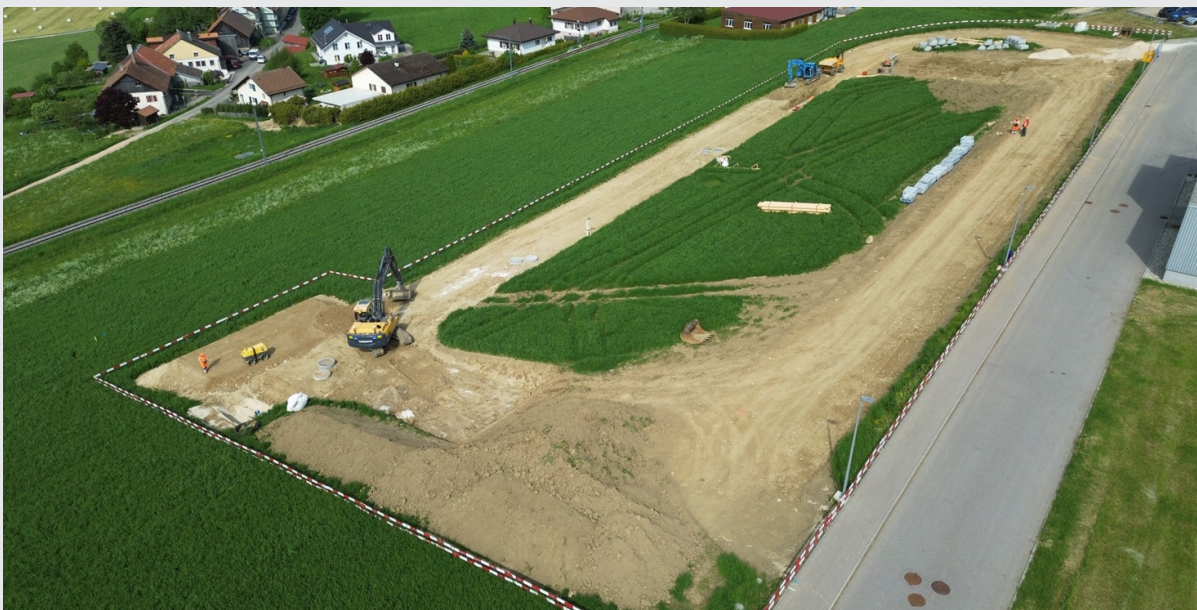
Travaux de terrassement
