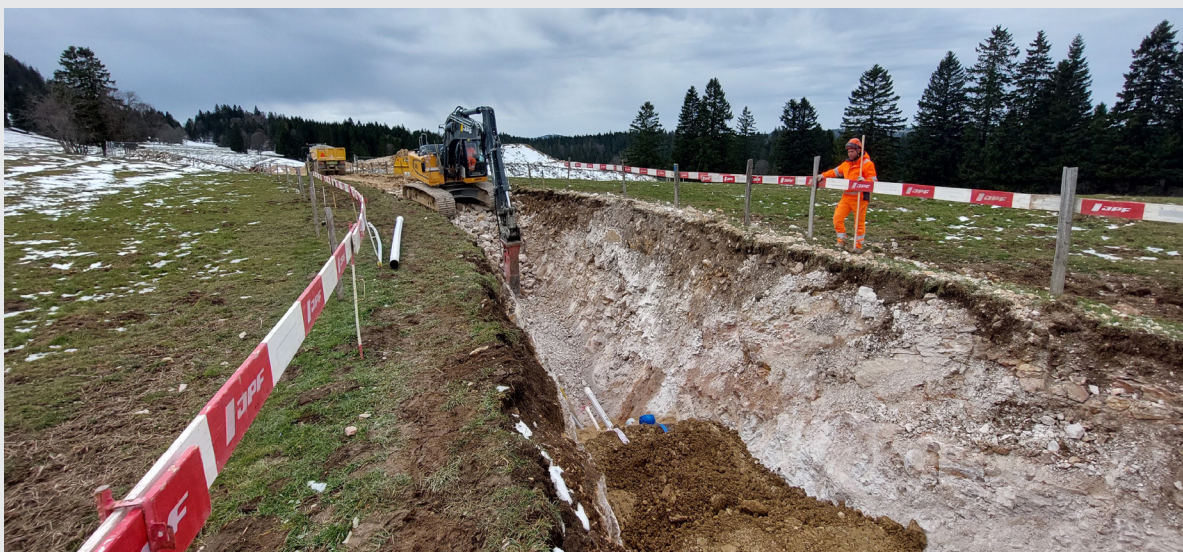
Fouille pour la pose des conduites reliant la Gittaz-Dessus au nouveau réservoir
