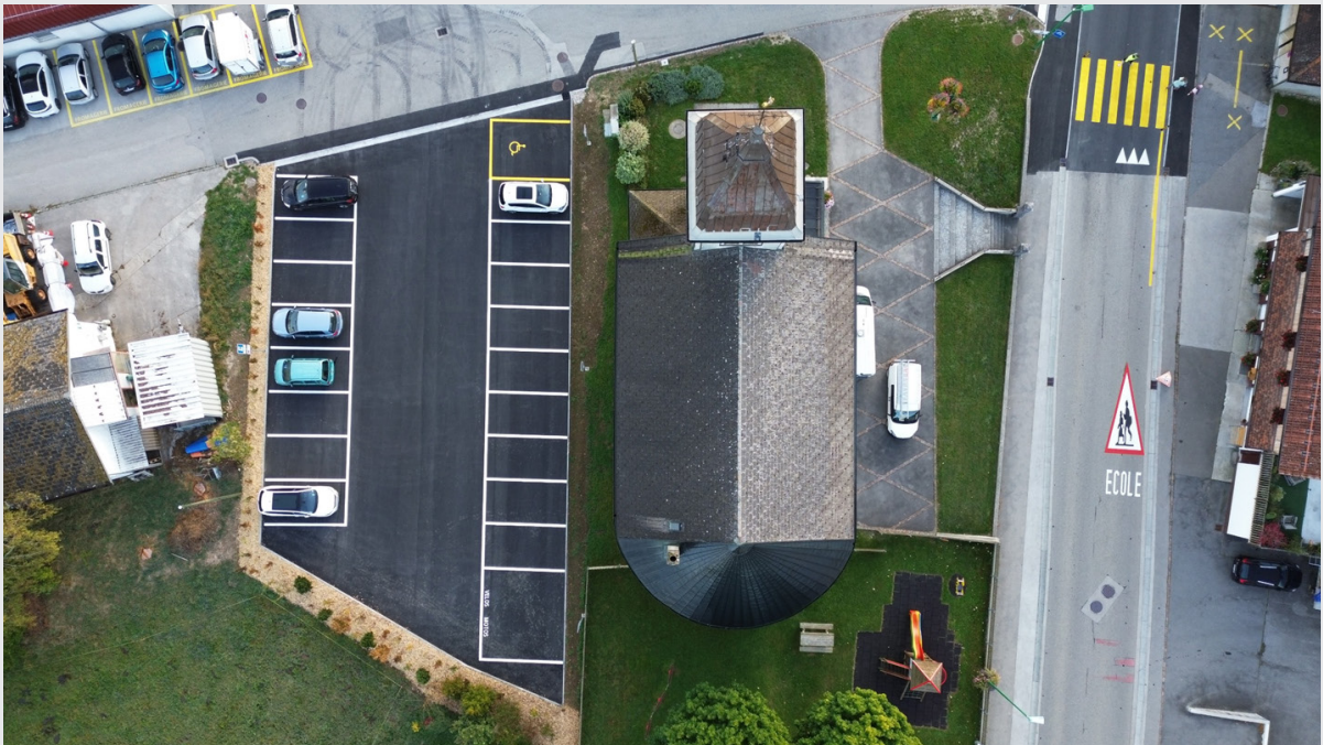
Situation après travaux
