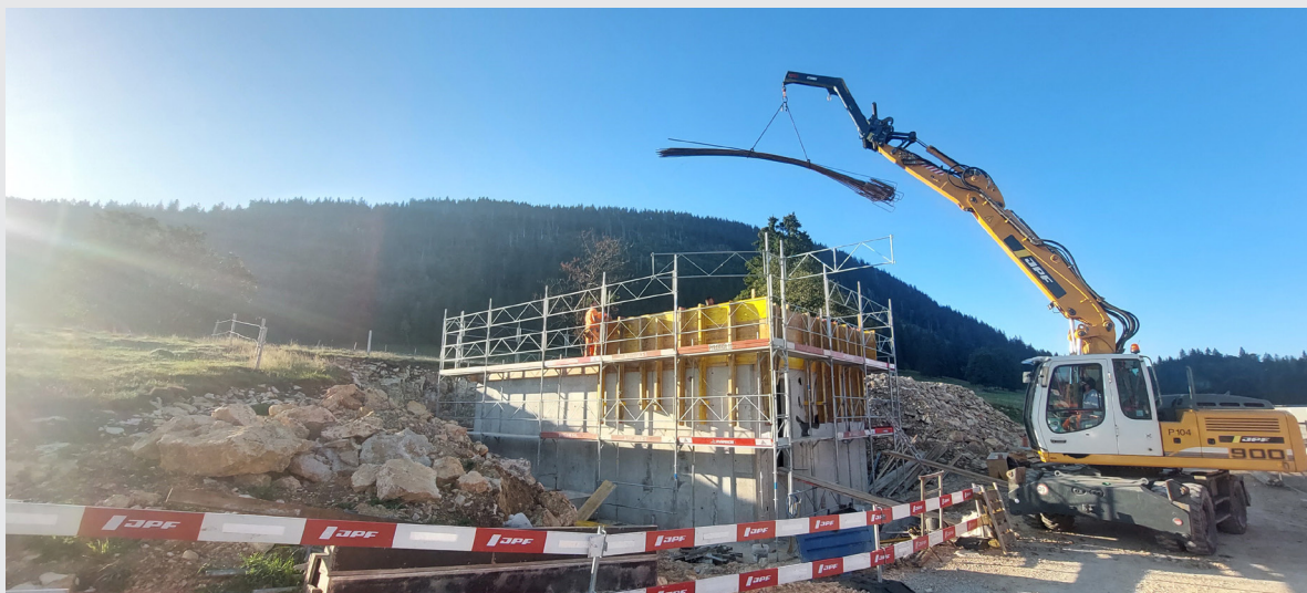
Création d'un nouveau réservoir de 100 m 3 à la Gittaz-Dessus
