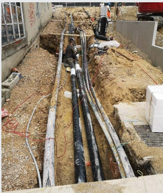
Travaux partie Primaire CAD
