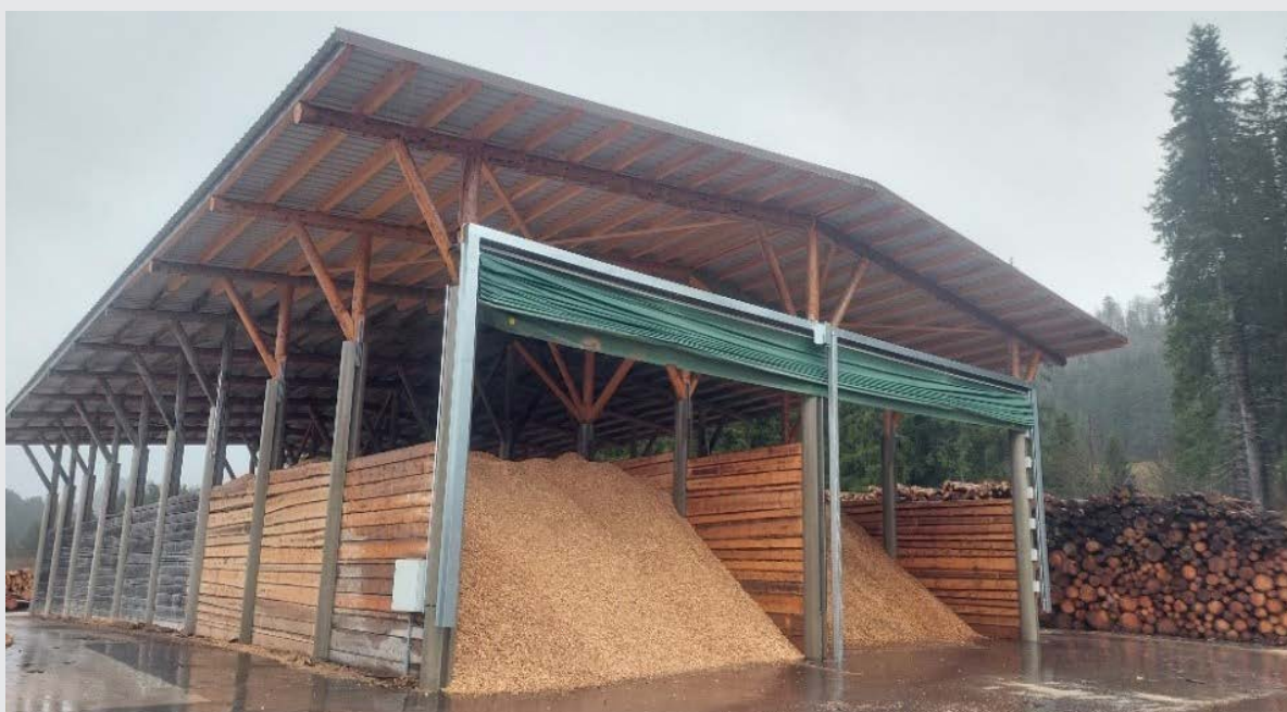
Débuté en 2021, l'agrandissement du couvert à plaquettes s'est terminé en 2022
