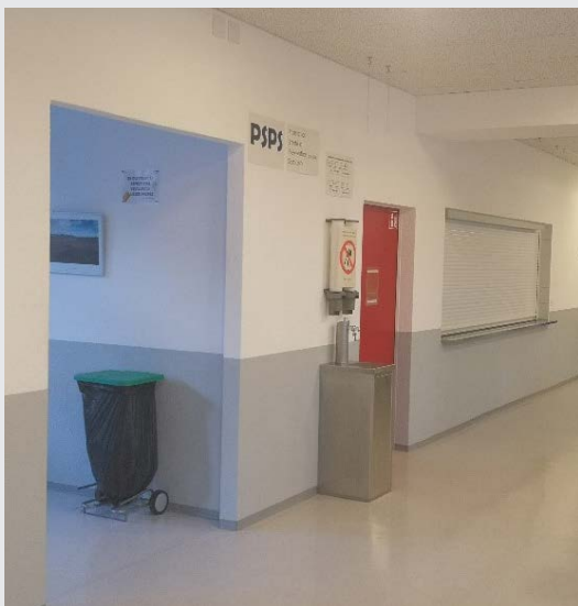
Réfection des peintures du réfectoire à La Conversion
