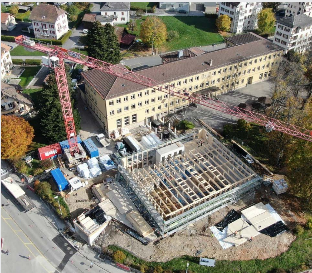
Chantier nouvelle salle de gym de la Gare (octobre 2022)
