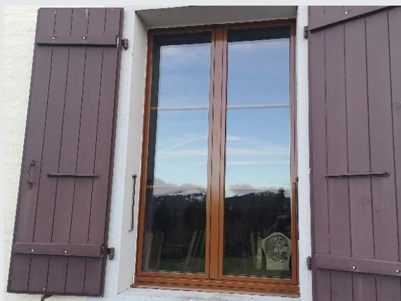
Remplacement des fenêtres au Mont-de-Baulmes Dessus
