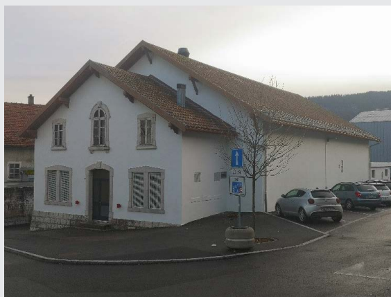
Peinture des façades de la salle de gymnastique de la Poste
