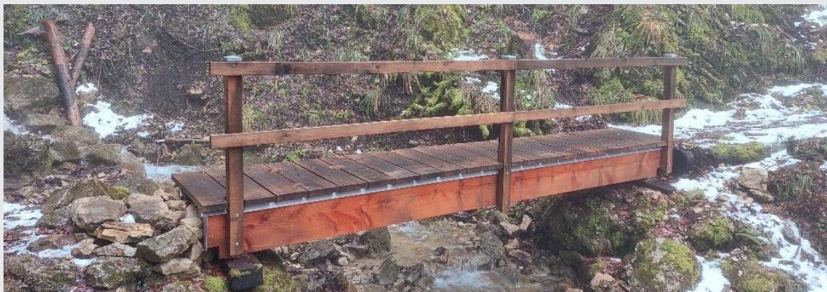
Une des quatre nouvelles passerelles mise en place au Saut de L'Eau durant l'été
