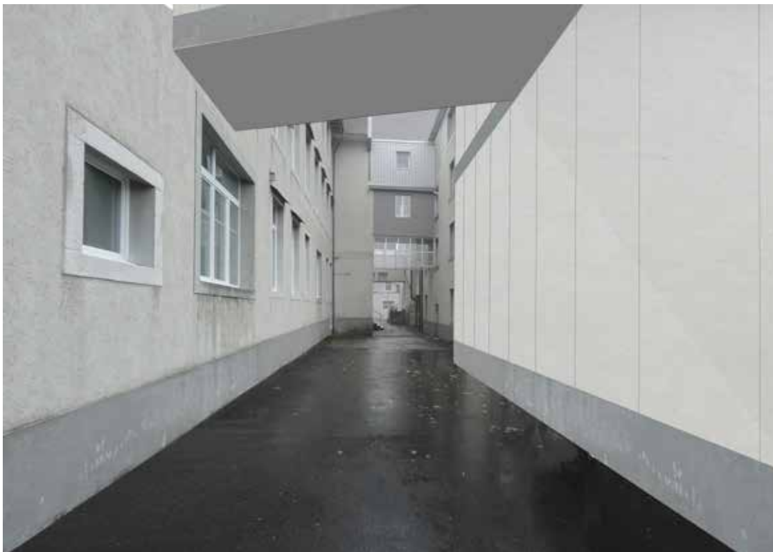
Liaison entre la structure existante et la nouvelle construction s'intégrant aux anciens bâtiments présents
