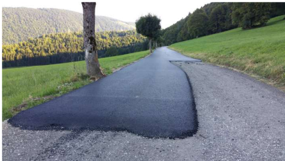
Pose d'un revêtement bitumineux sur une fondation stabilisée à la route des Gittaz
