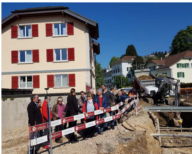
La commission de gestion sur le chantier de la rue du Jura
