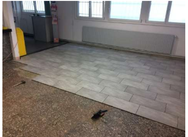
Carrelage Office de poste
