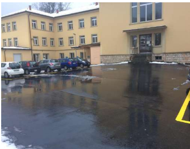
Enrobé Collège de la Gare
