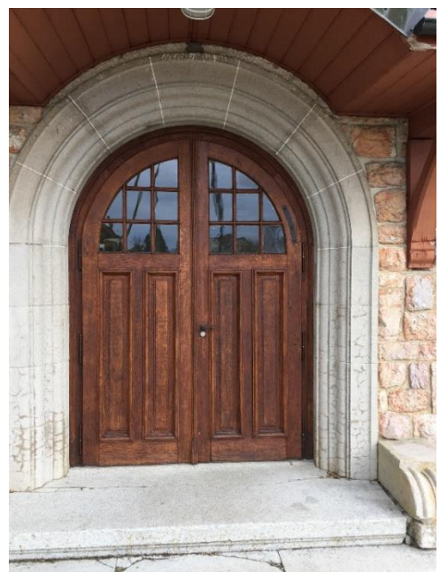
Porte d'entrée du local de gym de La Chaux
