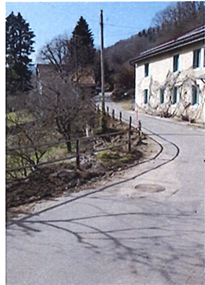
Chaussée et garde-corps
