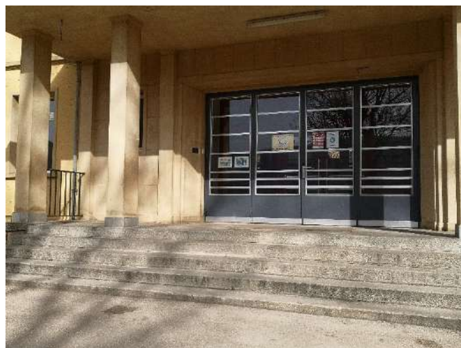
Peinture portes Collège de la Gare
