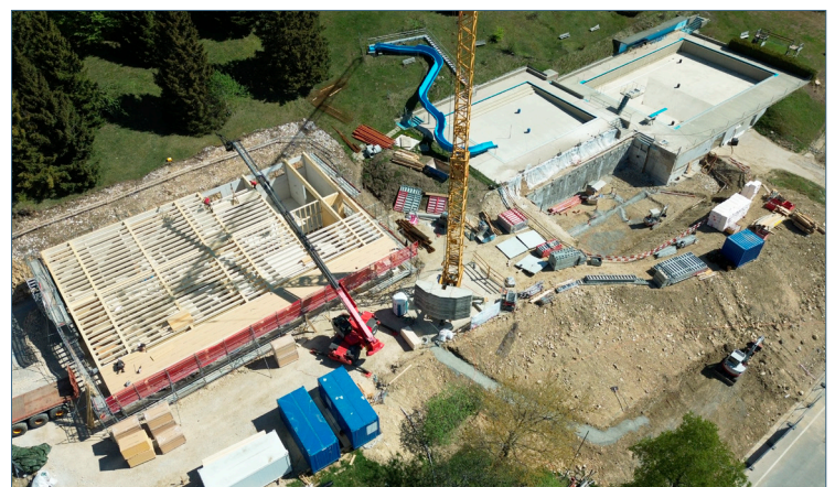
2025-2026 | Début des travaux du site Alti'Loisirs.
