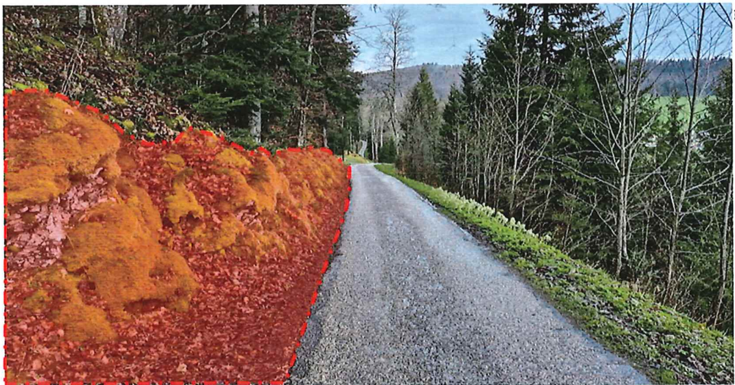
Exemple de secteur nécessitant une reprise de talus, Illex, 04.2024
