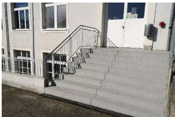
Nouvel escalier à La Conversion
