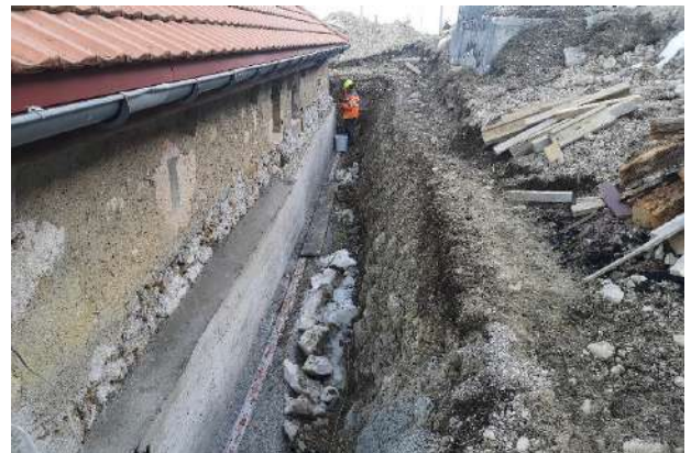
Drainage des façades Mont-de-la-Mayaz
