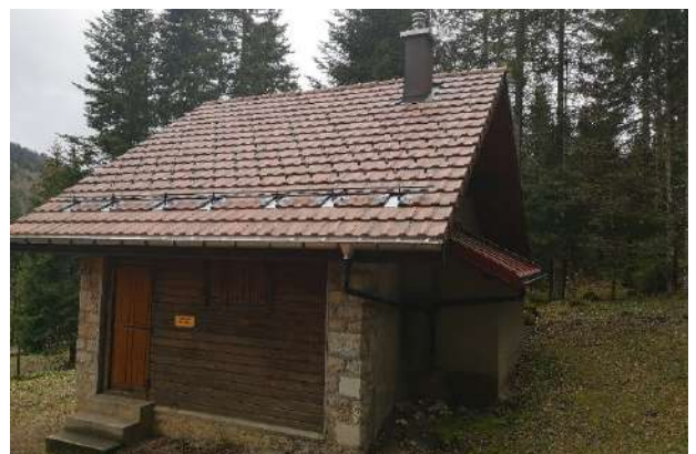
Rénovation des façades de la Vy-Jaccard
