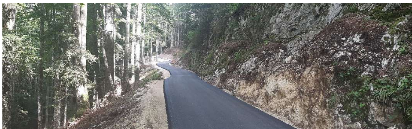
La route de L'Onglette après la pose de l'enrobé bitumineux
