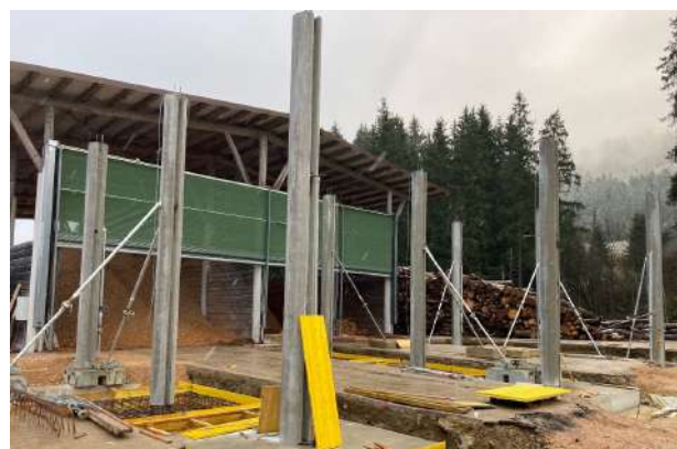
Agrandissement du couvert à plaquettes : Mise en place des piliers
