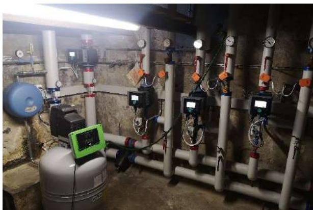
Travaux partie secondaire Chauffage à distance
