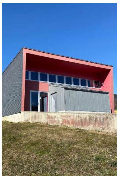
Caserne SDIS, nouveaux locaux décontamination et déchets
