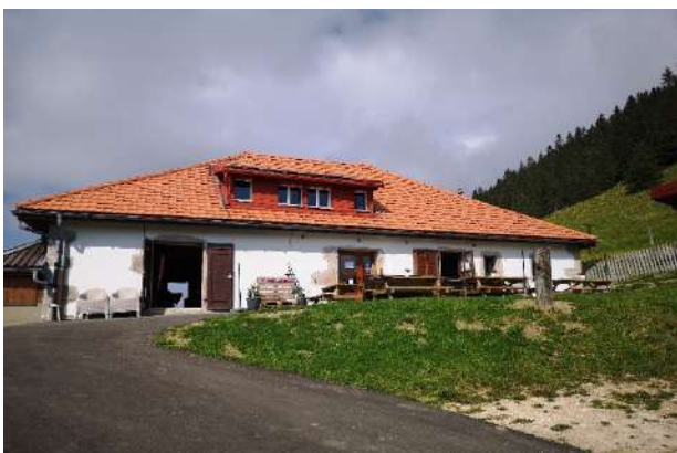
Rénovation des façades Mont-de-la-Mayaz
