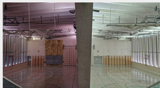
Remplacement des luminaires au Centre Sportif (Avant /Après)
