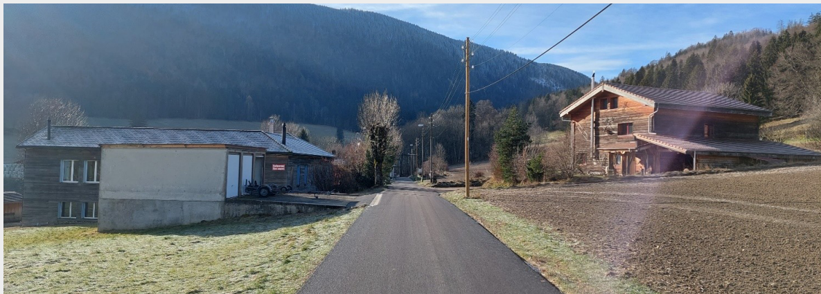
Réfection de la route de Culliairy
