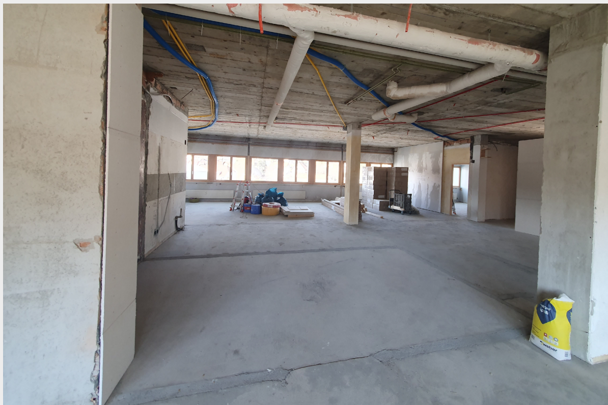
Situation après démontage et désamiantage
