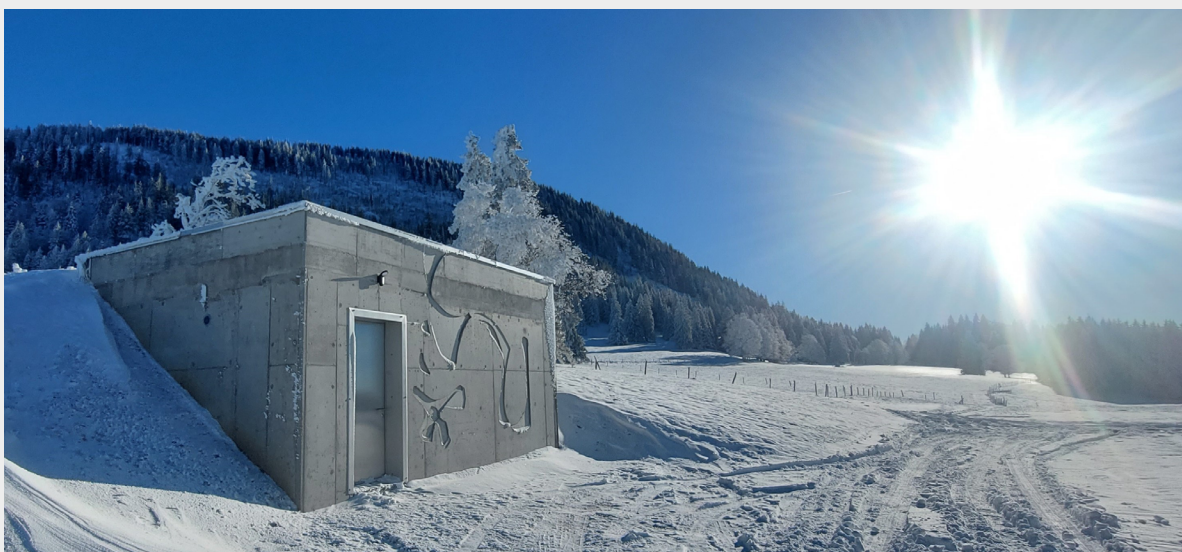
Vue extérieure du nouveau réservoir des Gittaz
