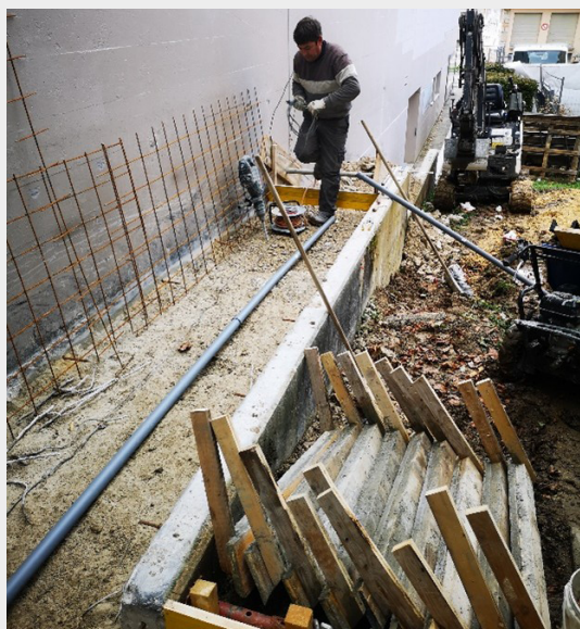
Réfection des escaliers extérieurs à l'Hôtel-de-Ville
